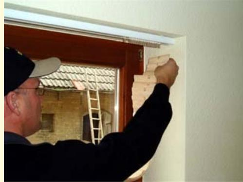
Haken müssen quer zur Schiene positioniert sein (mit Kuglkette ausrichten) und Stoffe einklicken
